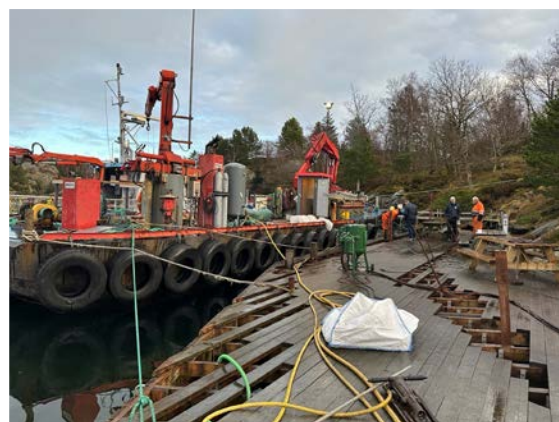
Det er utført et betydelig vedlikeholdsarbeid på bryggen. Arbeidet skal være ferdig innen 15. februar.
