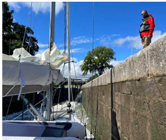
Gøtakanalen med historiske cruisebåter tilpasset slusene og plass til to seilbåter.
