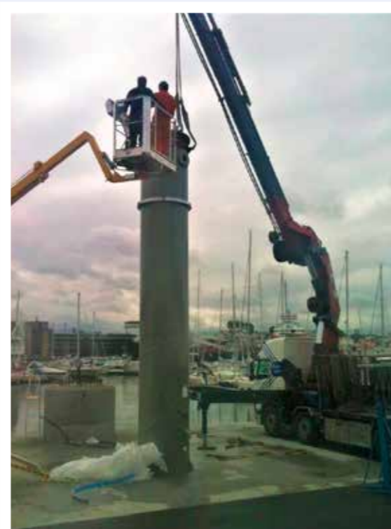
Sommeren 2012 ble den nye kranen montert på servicebryggen på Sølyst. Legg merke til det ekstra høye fundamentet til venstre i bildet, som kransøylen ble montert på og som ga kranen mer løftehøyde. Foto: Carsten Bowitz.
