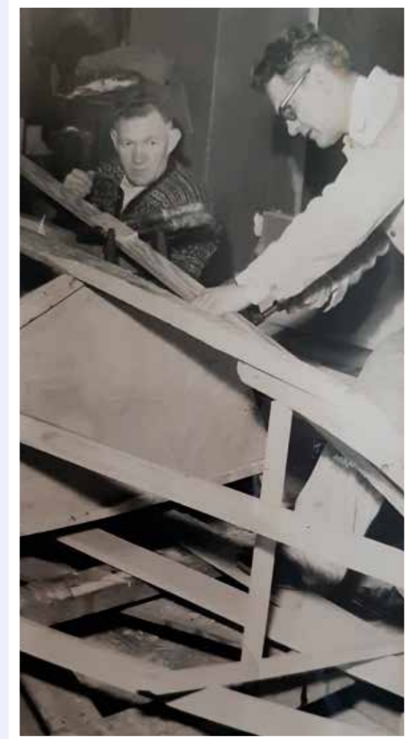
Bygging av OK-jolle i kryssfiner.
