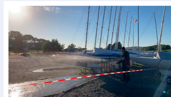
Pål Bentsen vanner nylagt betong for utvidelse av oppstillingsplass for båtene.
