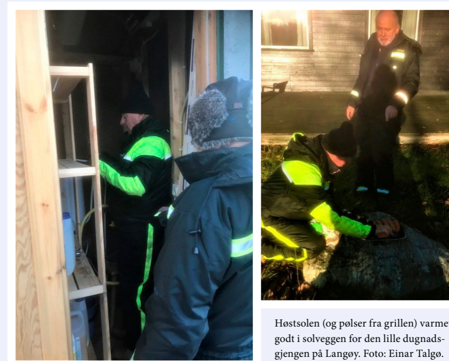
Frode og Per i gang med å stenge av og tømme varmtvanns-berederen i toalettbygget. Foto: Einar Talgø.
