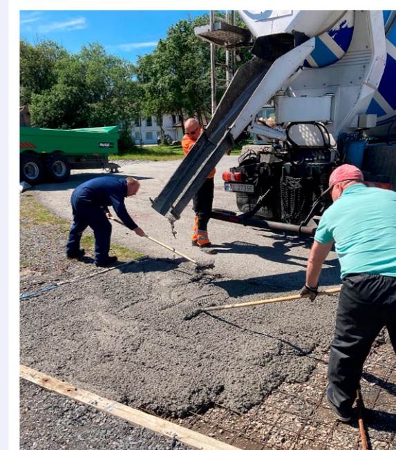
Frank Huth og Rune Nor Hansen fordeler betong i god og ekte dugnadsånd.
