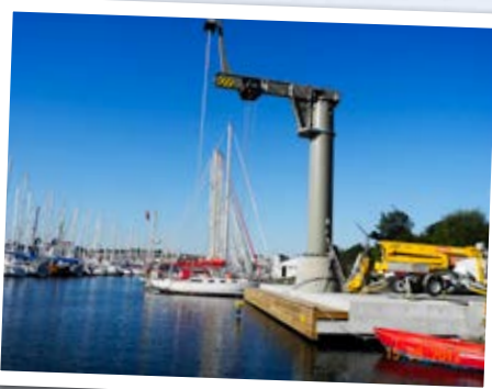
Montering av ny kran
